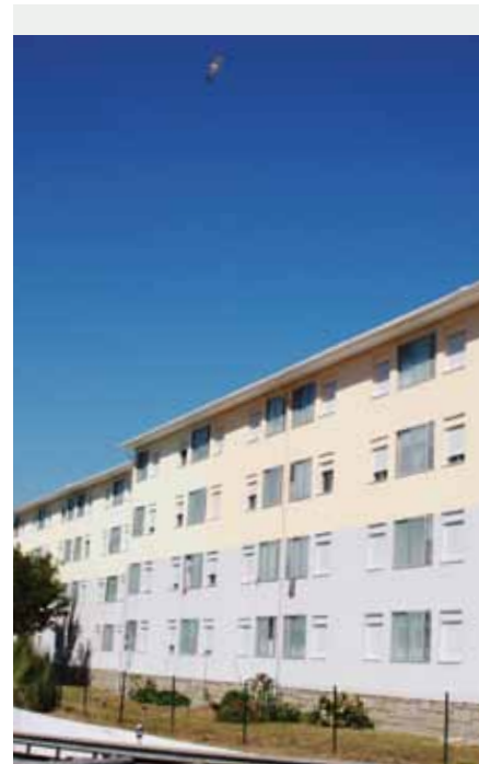
Reabilitação do Bairro de Francos 3ª fase – Porto
